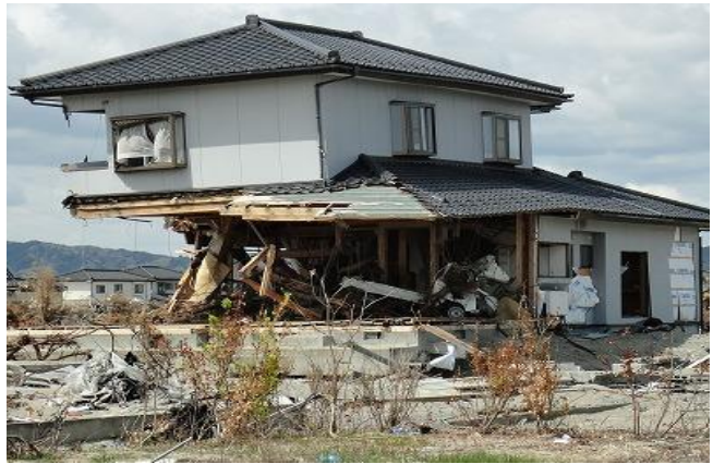
その場に残ったが、残骸となってしまった住宅
