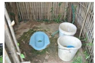
手桶水洗式のトイレ。汚水は地下浸透。
