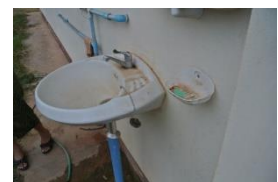
調製作業室の水道
