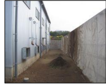
集塵機と飛散防止囲い
