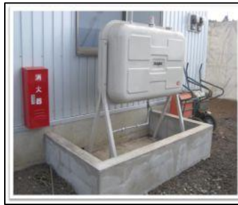
新たに設置した防油堤
