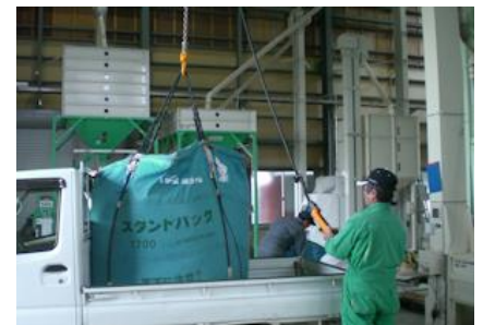
ヘルメットなしのクレーン操作
