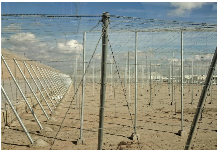
新築中の平張ハウス 台風などないのでパイプも細い。
